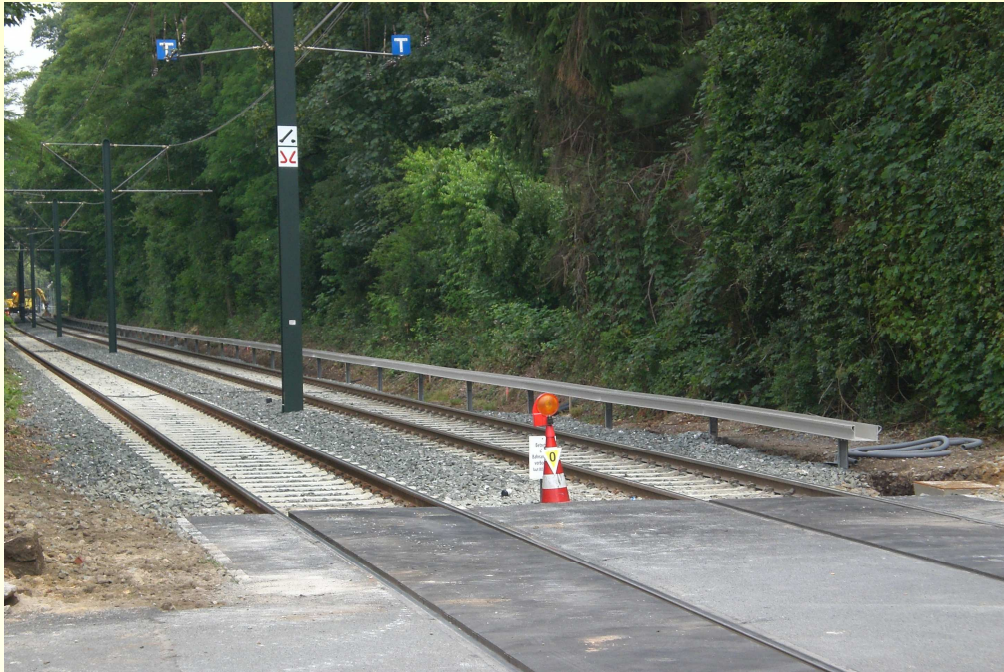
Aufgeständerter Kabeltrog entlang der U72
