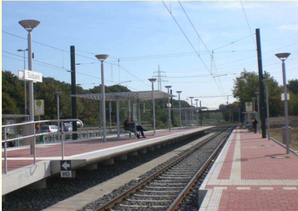
neu gebaute Hochbahnsteiganlage
