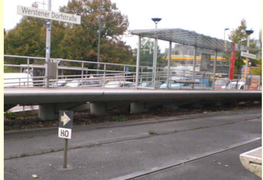
Anbindung an vorhandene Hochbahnsteiganlage
